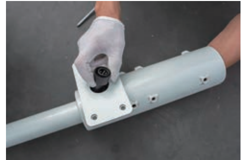
6. 穴から風力発電用のケーブルを取り出します。
