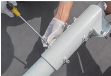
8. 外灯のポールを接続ソケットに挿入し、ネジで固定します。
