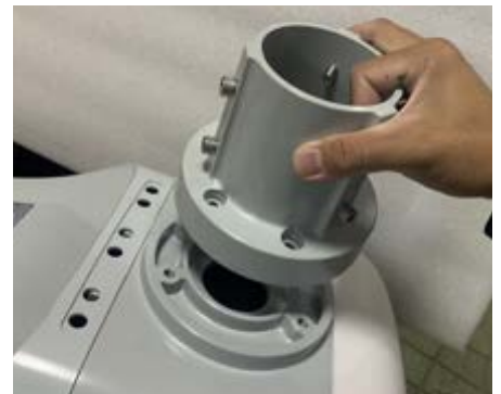
③ポールにかぶせる為の金具を取り付けます。
