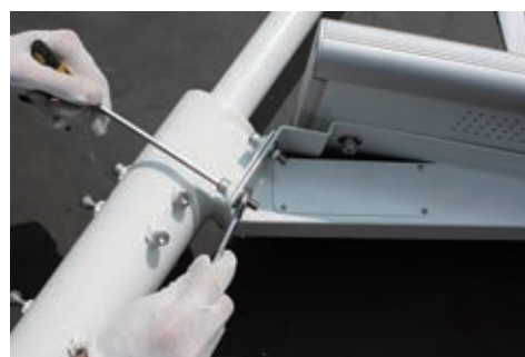
9. ソケットと照明をネジで固定し、風力発電用ケーブルをブラケットに挿入します。
