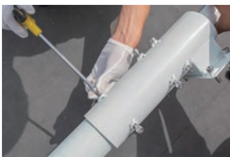
8. 外灯のポールを接続ソケットに挿入し、ネジで固定します。
